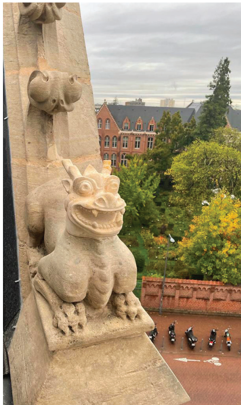
La chimère orne à nouveau le toit de l'hôtel académique de la Catho. Créature hybride, elle se « contente » de décorer, tandis que les gargouilles « crachent » l'eau d'écoulement.
