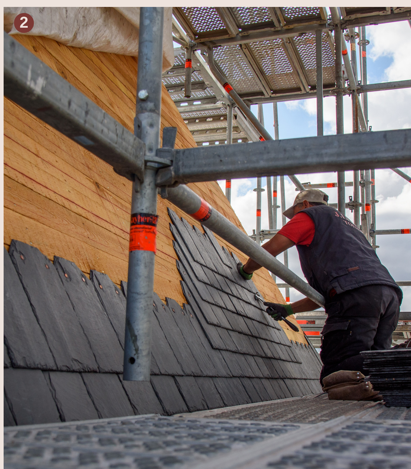
Pose des nouvelles ardoises sur le voligeage neuf du clocher
