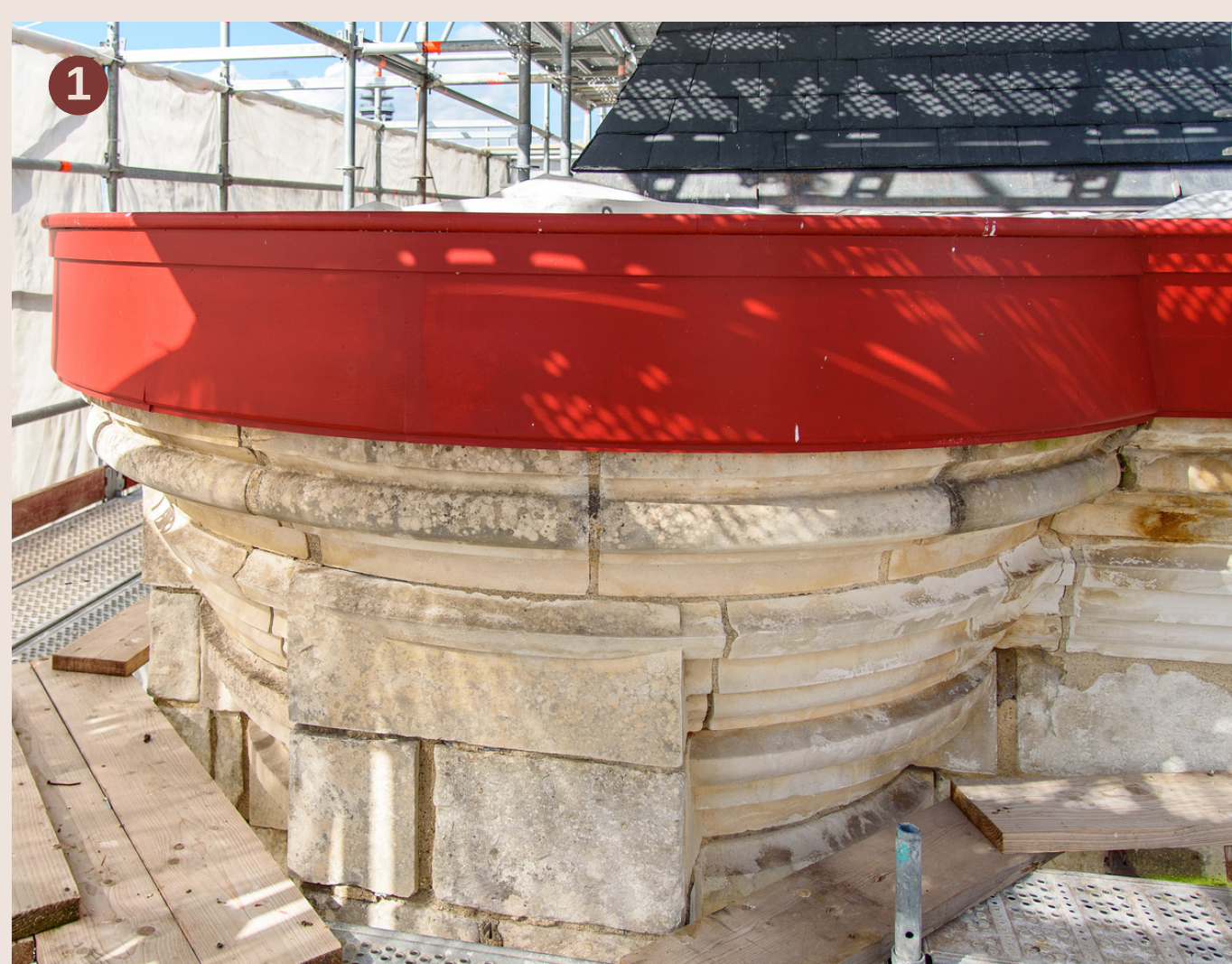
Création d'un nouveau chéneau cintré qui suit les courbes de l'édifice et finition en rouge sang de bœuf*
