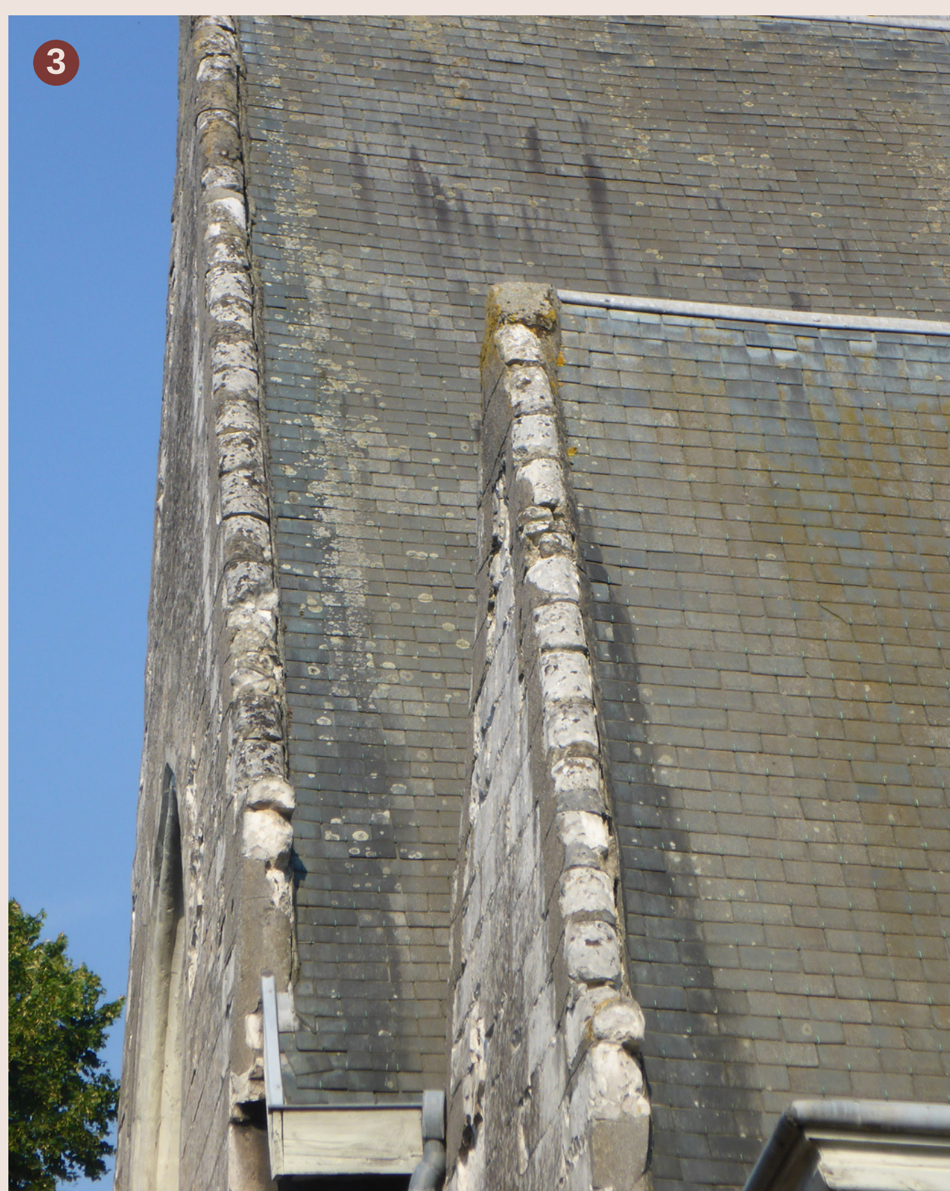
3 Transept façade sud : absence de solin entre la couverture et le mur pignon en pierre
