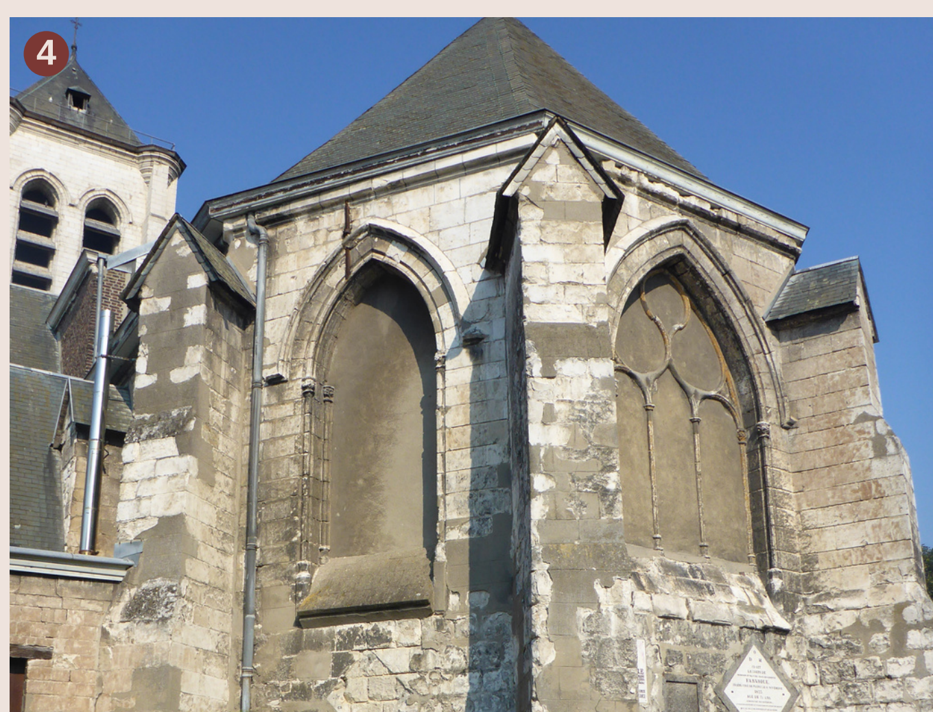
Disparition des panneaux vitrés des baies du chevet
