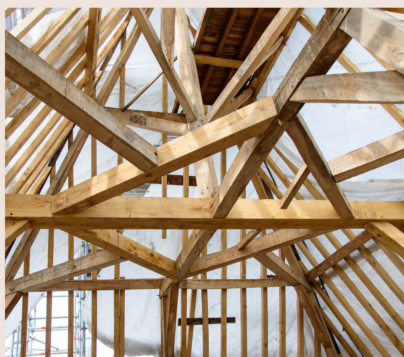
Restauration de la charpente en cours, assemblage des anciennes et nouvelles pièces de bois
