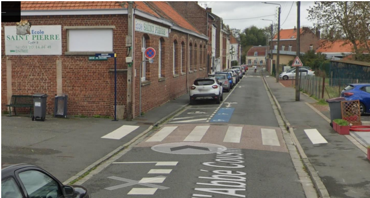
Panneau Lumineux EP + plots solaires (x8)
