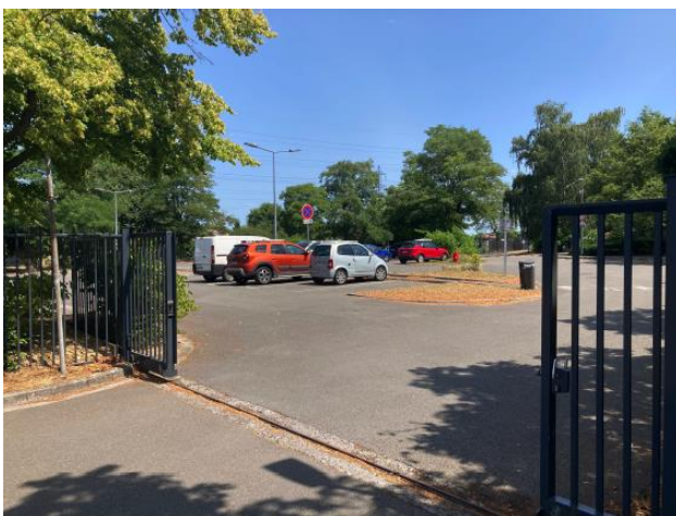
Projection avant/après la pose d'ombrières photovoltaïques sur le parking du Centre Nautique Babylone
