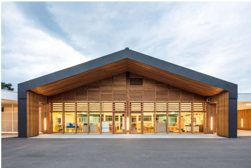
Atelier A Architectes Groupe scolaire Vétraz-Monthoux (74)
